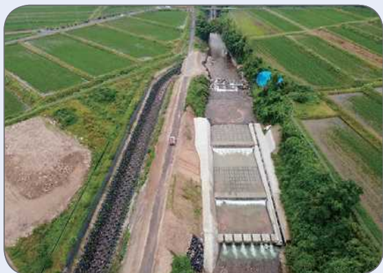
改修中の農業用河川工作物
