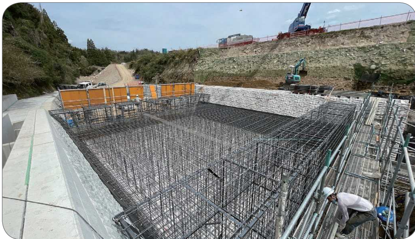
農業用河川工作物応急対策工事（高島市）
