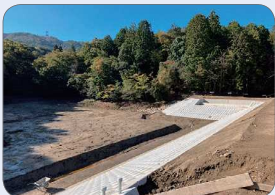
耐震改修中の千町新池
