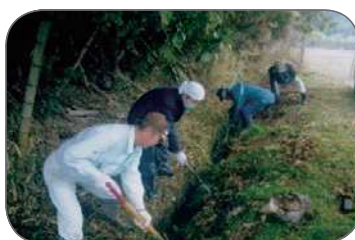
水路の泥上げ
