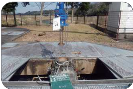
沈殿槽汚泥掻き機の減速機更新
