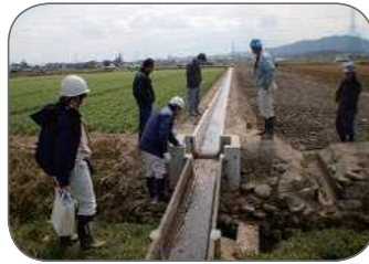
老朽化した用水路の補修・更新
