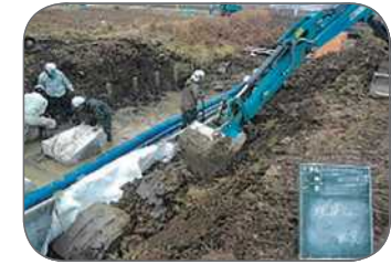
生物多様性に配慮した排水路の補修・更新
