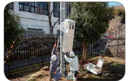
引込開閉器盤更新
