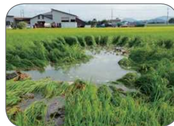
圧送管の破損による被害
