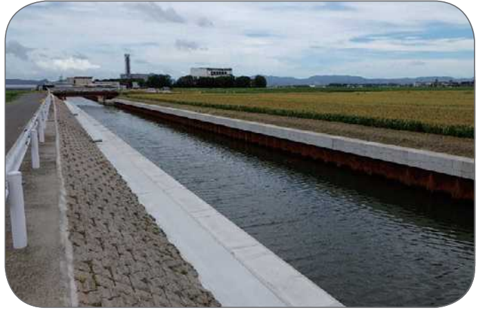
水路（排水路）の更新（守山市）
