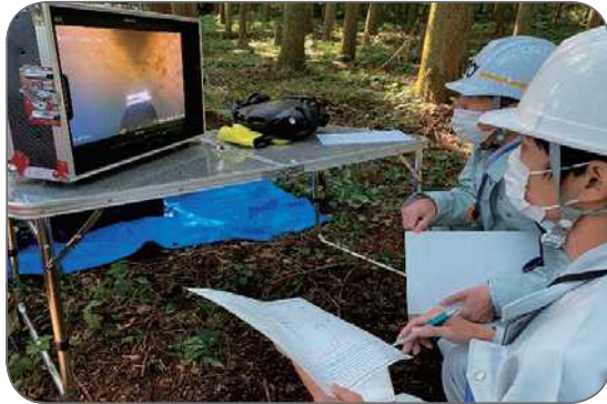
用水路の内部状況を診断するためのビデオカメラ調査
