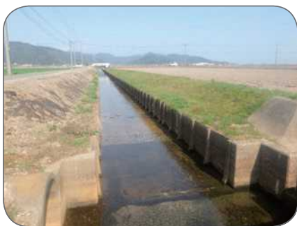
排水路の整備（近江八幡市）
