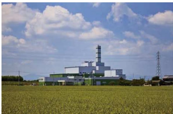
近江八幡市一般廃棄物処理場 近江八幡市
