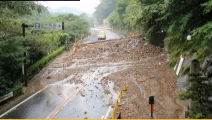
大雨による法面崩壊(平成24年8月)により約80時間の通行止めが発生
