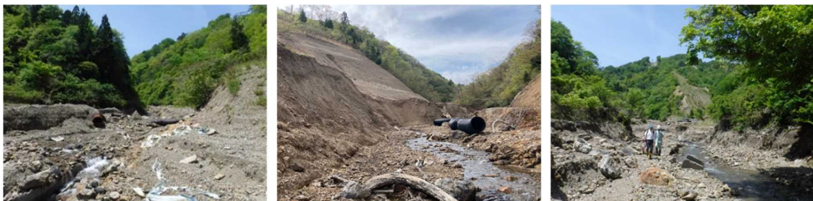
図8: 現地調査状況 (大音波谷川、スキー場跡地)
