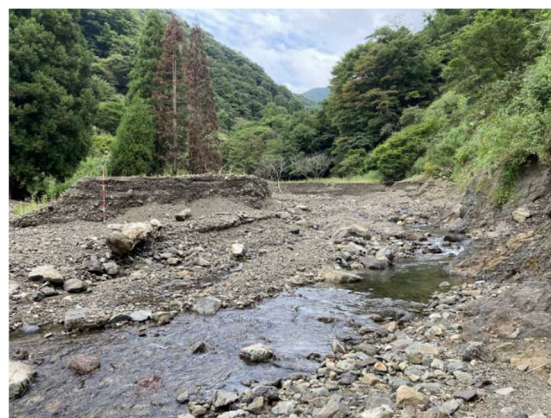
図11： 既設砂防堰堤の堆砂状況（針川）
