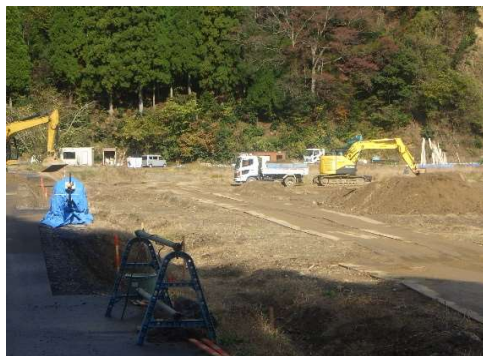
農地の復旧（堆積土砂の搬出）
