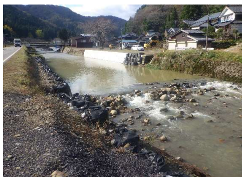
河川内沈砂地設置による濁水発生抑制
