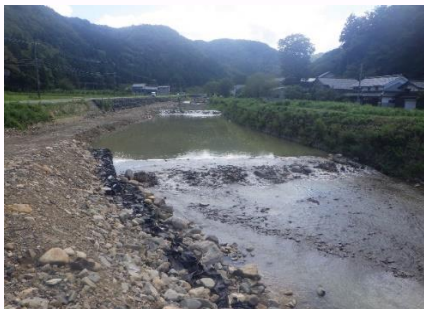
河川内沈砂地設置 濁水発生の抑制： 環境にやさしい災害復旧工法
