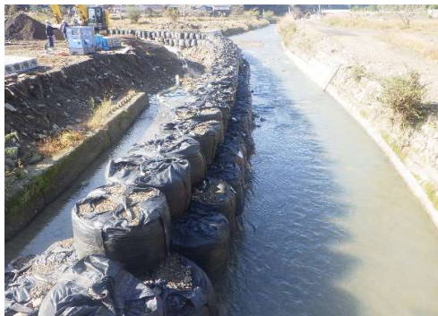
護岸工事の状況
