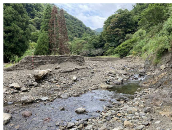
図11： 既設砂防堰堤の堆砂状況（針川）
