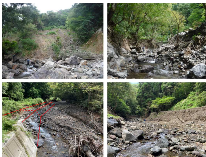
図10： 現地踏査状況（針川）
