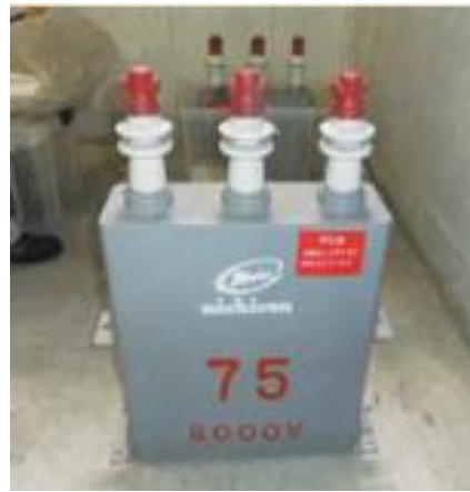
電力用コンデンサー
