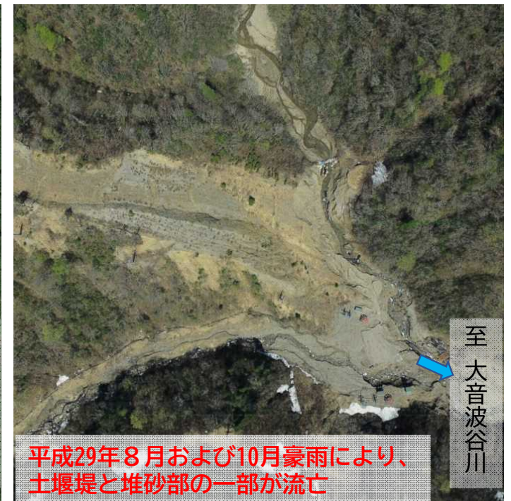
平成29年8月豪雨後のスキー場最下流部の様子 平成30年(2018年)4月19日、ドローンで撮影)
