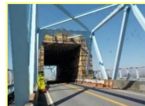
修繕 (塗装塗替) 状況 【彦根米原線 (米原跨線橋)】
