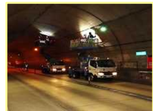
点検状況 【国道 421 号 (石樽トンネル)】
