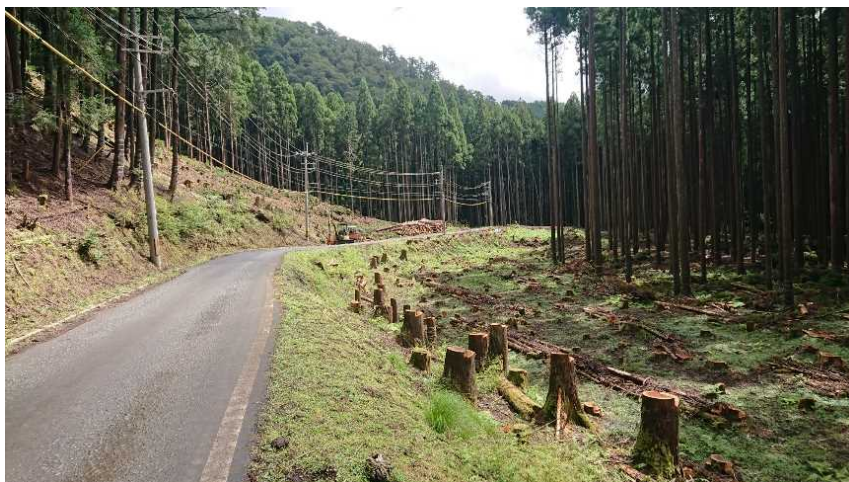
道路沿いの予防伐採を行った現場
