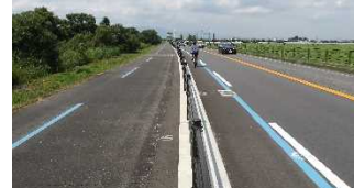
矢羽根による路面表示と案内整備、走行空間整備(拡幅)
