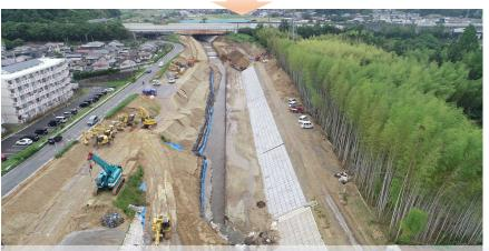
2023年5月:仮設落差工設置、左岸大型張ブロックエ
