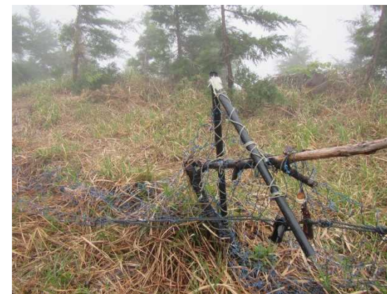
風雪で折れた獣害防護柵の支柱
