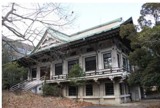
図3-1 旧体育文化館(武徳殿)の外観
