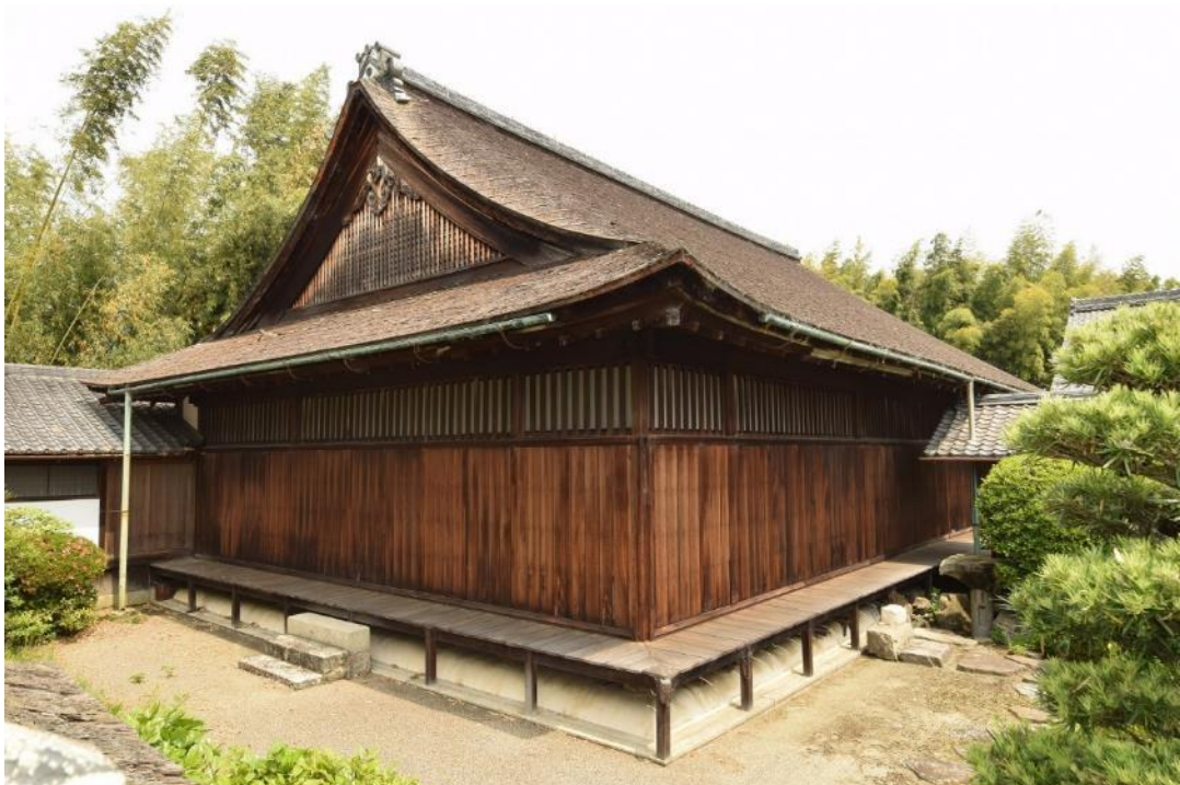
重要文化財聖衆来迎寺客殿 修理前 正側面（南東面）全景
