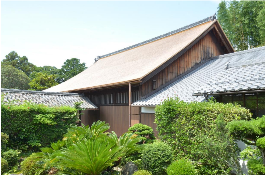
重要文化財聖衆来迎寺客殿 修理後 正側面（北東面）全景
