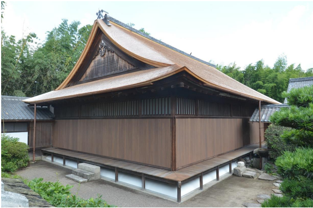
重要文化財聖衆来迎寺客殿 修理後 正側面（南東面）全景
