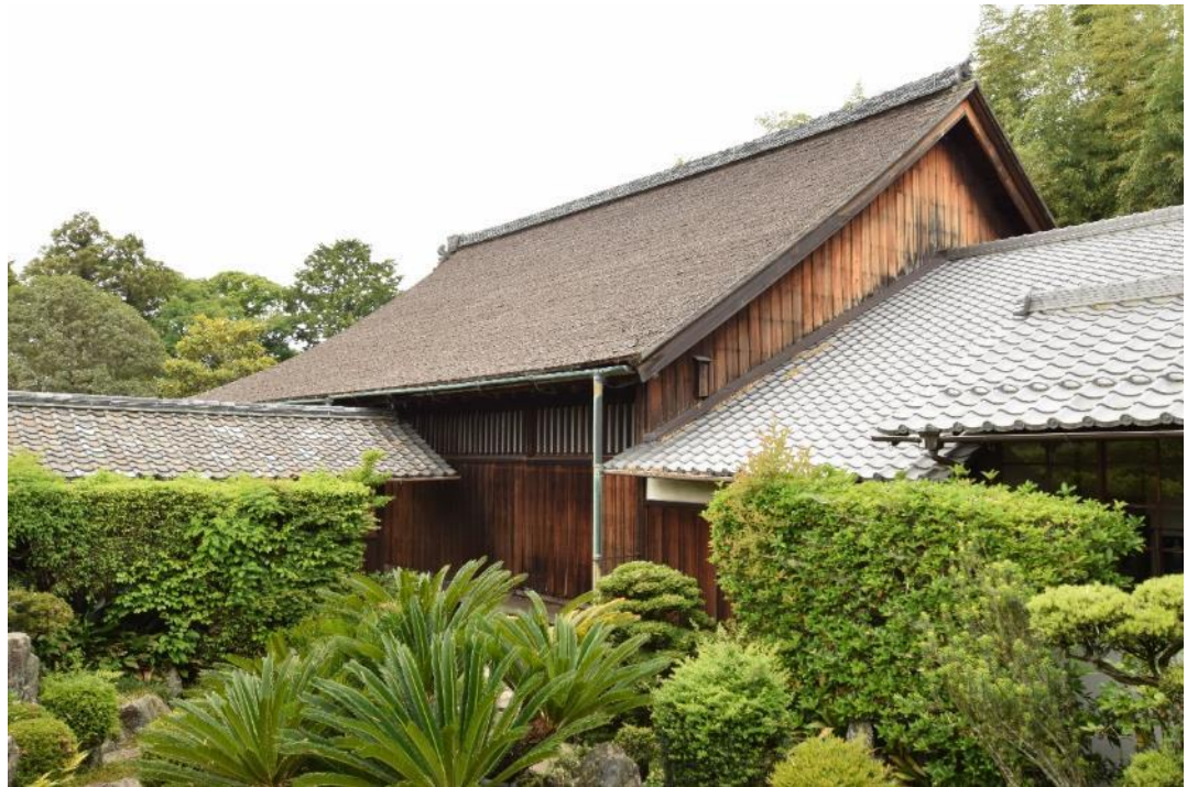
重要文化財聖衆来迎寺客殿 修理前 正側面（北東面）全景
