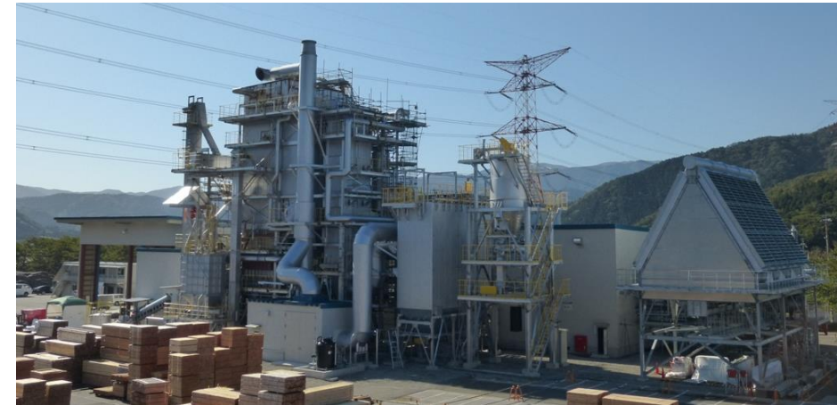
いぶきグリーンエネルギーバイオマス発電所
