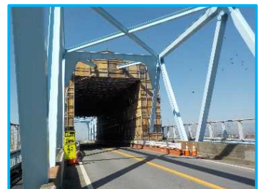
修繕 (塗装塗替) 状況 【米原跨線橋】
