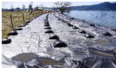
湖岸の石組み護岸での遮光シートの敷設
