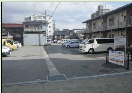
雨水貯留式公用車駐車場(彦根市)
