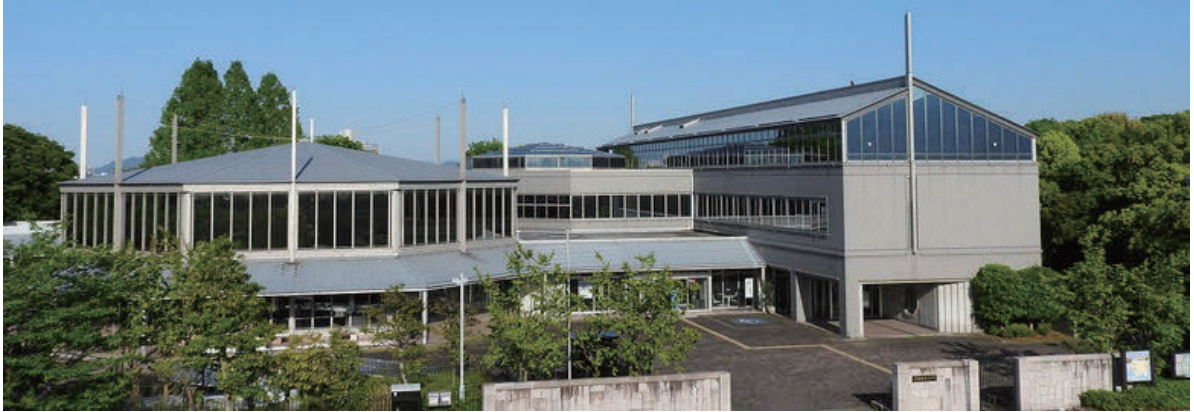
淡海環境プラザ外観
