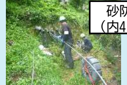
砂防施設の点検
