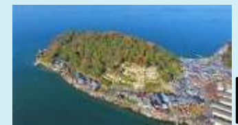
環境配慮型マットによる法面工
