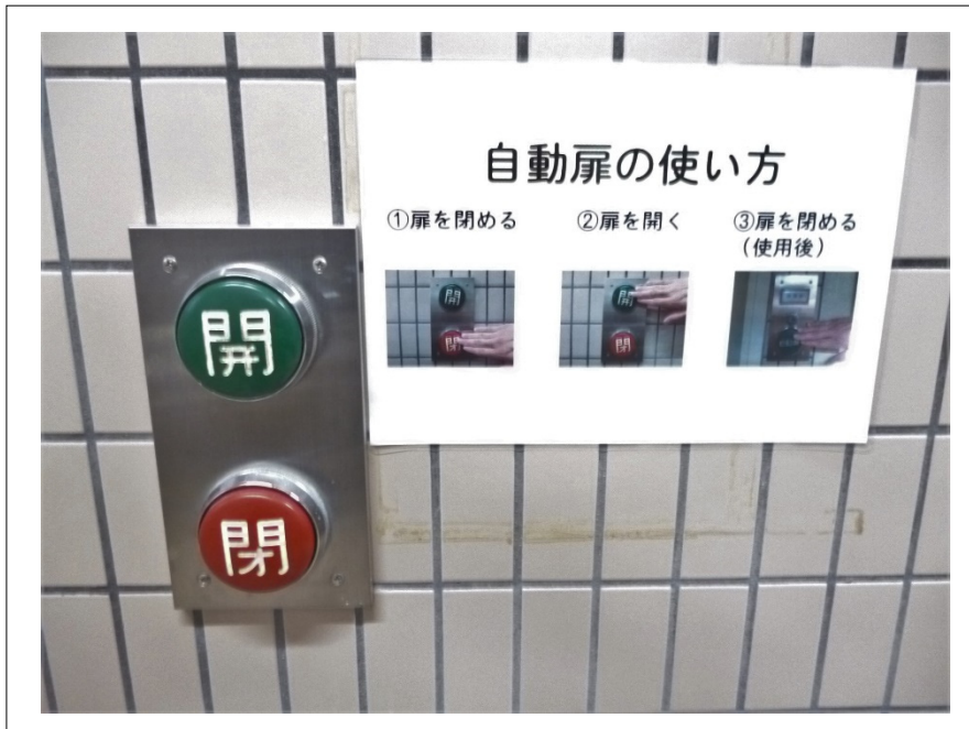
図 I.3.5.4 多目的トイレ出入口ドアスイッチ (わかりやすいスイッチ)
