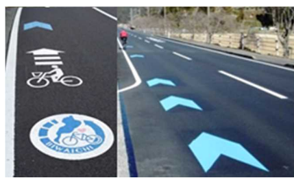
矢羽根による路面表示と案内整備、 走行空間整備（拡幅）
