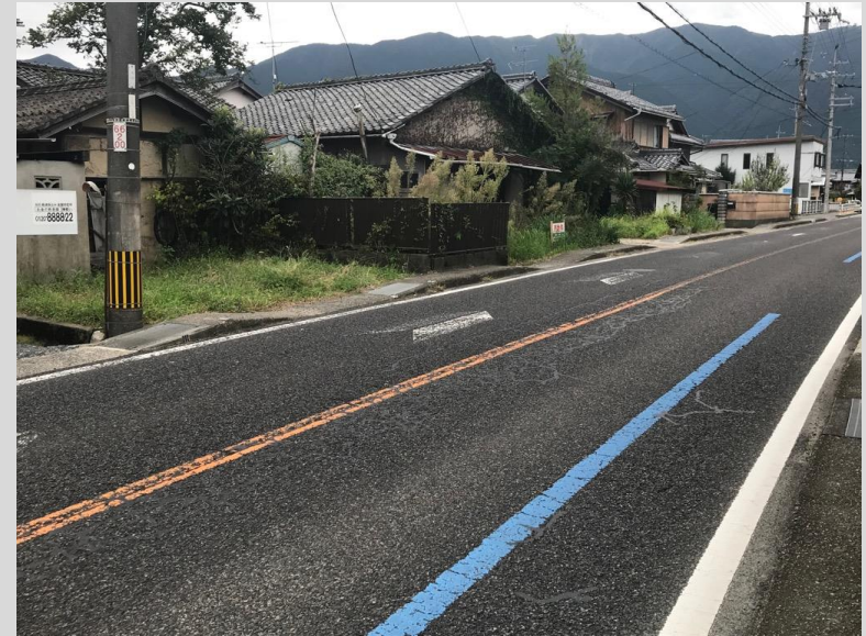
県道 高島大津線 マウンドアップ型歩道状況
