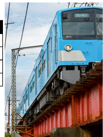
築造後100年以上経過する橋梁
