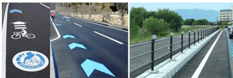
矢羽根による路面表示と案内整備、走行空間整備（拡幅）
