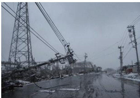
災害時における電柱の倒壊状況
