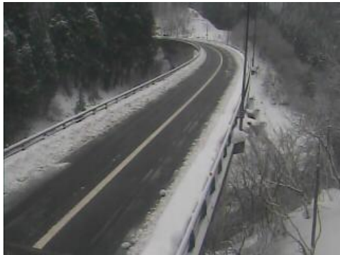
地中熱を利用した融雪装置を有する橋梁 (国道 303 号八草大橋)
