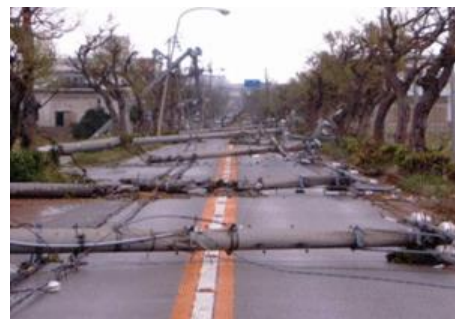
災害時における電柱の倒壊状況
