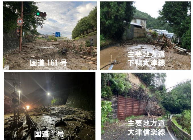
令和3年8月の大雨による道路被害状況
