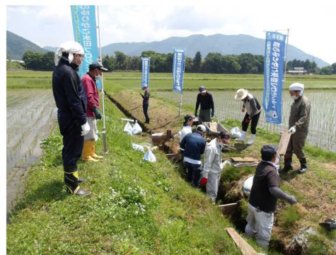
写真 魚道設置のようす 5月22日 高島地マキノ町知内
