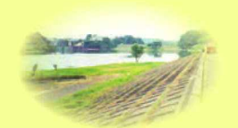
脇堤は表面を保護するコンクリートが見える
