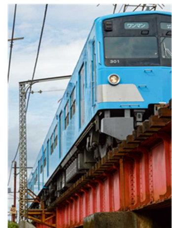
築造後 100 年以上経過する橋梁
