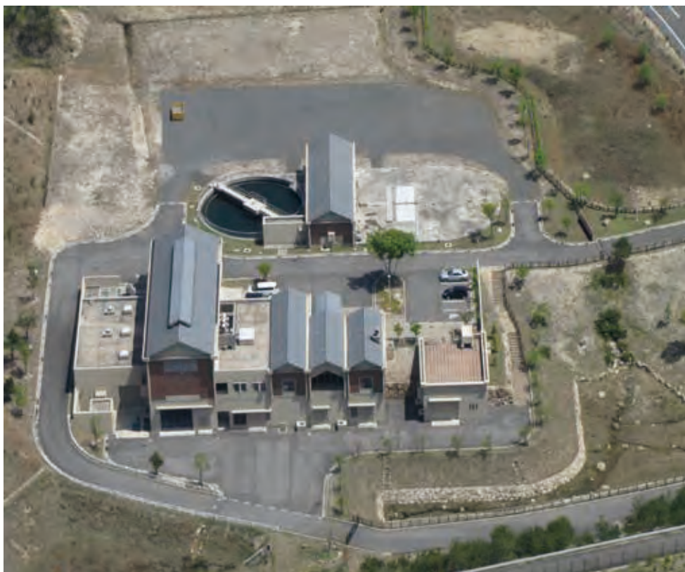
▲甲賀市信楽水再生センター
