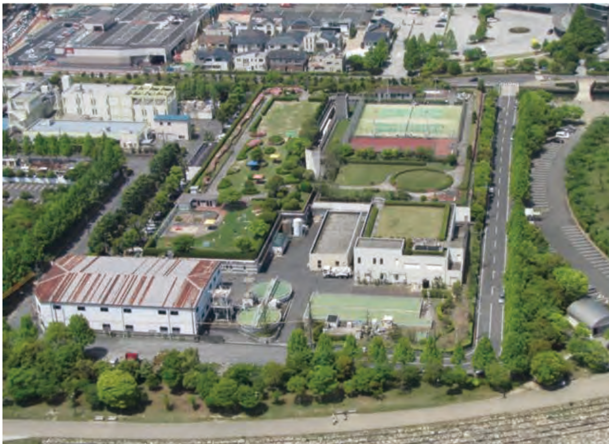
▲大津市水再生センター
