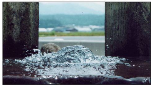
パイプライン噴出し口
