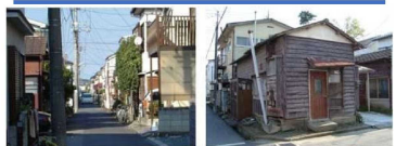
【側溝を入れて4mぎりぎり】 【分譲当初のままの平屋建て住宅(空き家)】
