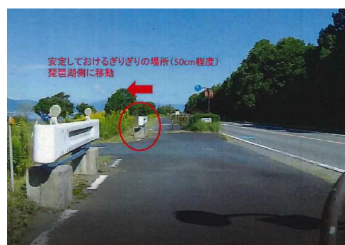
障害物(移動式ガードレール)
