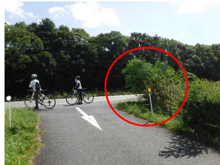
植栽による視距不良(車両進入口等)
