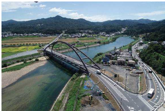
国道 422 号 大石東バイパス (瀬田川令和大橋(大津市))
