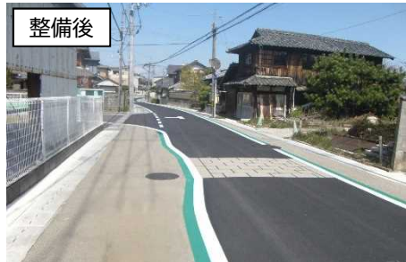
車両の通行規制(一方通行)と合わせ、歩行空間の拡充を行った事例 (大津能登川長浜線(守山市) 左:整備前、右:整備後)
