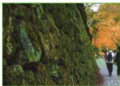
穴太積みの石垣がある坂本 (重要伝統的建造物群保存地区に指定) ▶田村安さんの応募作品
