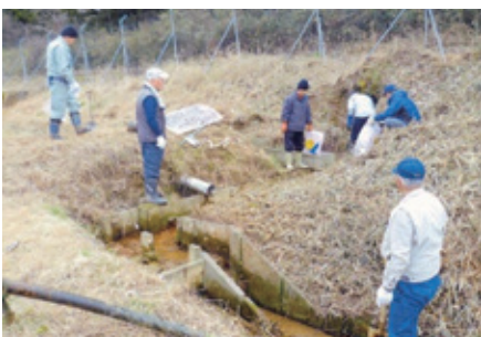
用水路補修前の掃除
