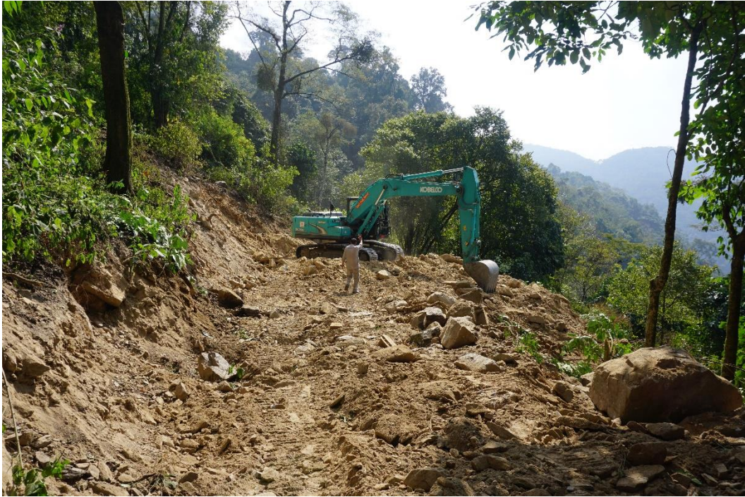
山奥道路建設現場
