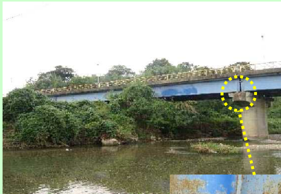
伸縮装置からの漏水等による支承部の劣化
