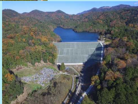
地震対策として改修した芹川ダム
