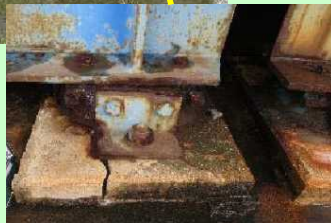
伸縮装置からの漏水等による支承部の劣化
