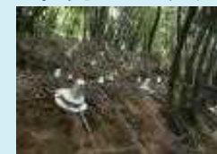
樹木を生かした法面工
