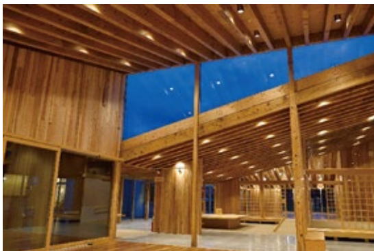
木造公共施設
