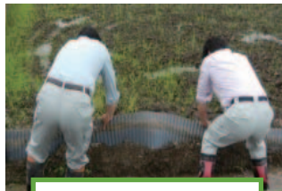
波板を押し込む
