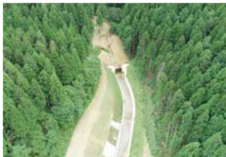
▲治山施設（流路工）
