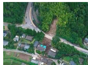
急傾斜地の崩壊
