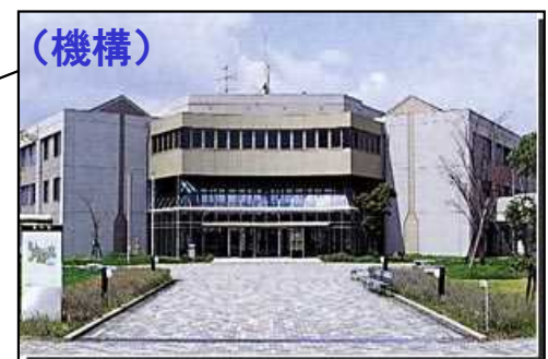
滋賀職業能力開発短期大学校 ＜滋賀職能大：近江八幡市＞
