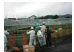
防護ネットの設置
