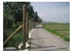
防護策の設置
